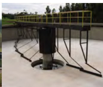
Sanepar / PR - Ponte Removedora de Lodo - \varnothing 35m - Distribuidor Rotativo para Filtro Biológico - \varnothing 32m
