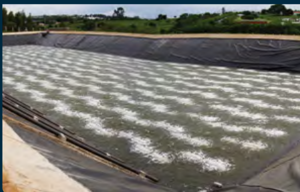
Sadia / MG Sistema de Aeração por Ar Difuso Difusores tipo Tubo 900 m 3 /h
