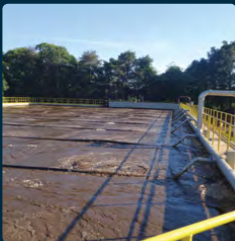
BRF / SC Sistema de Aeração Flutuante 550 m 3 /h
