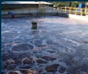
AmBev / PR Sistema de Aeração por Ar Difuso Difusores tipo Disco 70 m 3 /h
