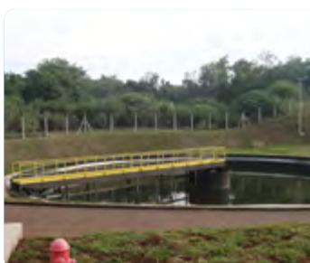
Sanepar / PR - Ponte Removedora de Lodo - \varnothing 35m - Distribuidor Rotativo para Filtro Biológico - \varnothing 32m
