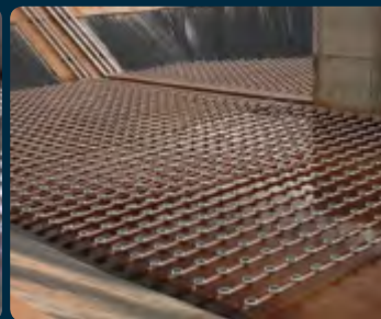
CAESB / DF Sistema de Aeração por Ar Difuso Difusores tipo Disco 2000 m 3 /h
