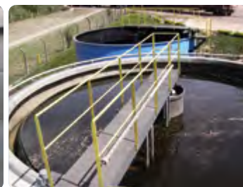
Imcopa / PR Adensador de Lodo
