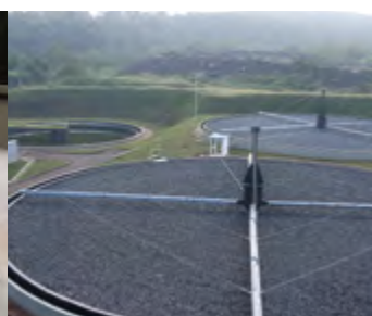
Sanepar / PR - Ponte Removedora de Lodo - \varnothing 35m - Distribuidor Rotativo para Filtro Biológico - \varnothing 32m
