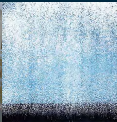
CAESB / DF Sistema de Aeração por Ar Difuso Difusores tipo Disco 2000 m 3 /h
